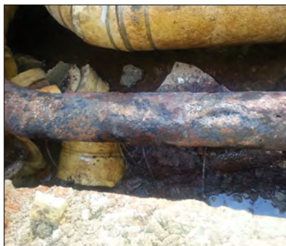
Rys. 2. Awaria rurociągu zasilającego budynek mieszkalny. Widoczne bardzo silne skorodowania zewnętrzne i perforacja rury. Widoczne strugi wody ciekącej z otworów w dolnej części rurociągu. (zdj. M. Chorzelski). Przynajmniej częściowo przykryty kanał. Rurociąg z przełomu lat 80 i 90 ub. wieku
