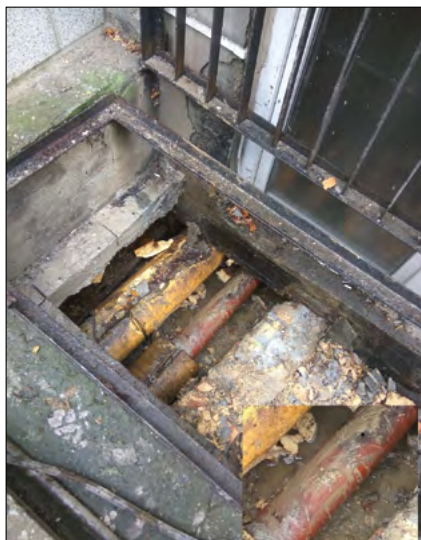
Rys. 1. Awaria rurociągu zasilającego – widoczny wizer korozji (zdj. M. Chorzelski). Przynajmniej częściowo przykryty kanał. Rurociąg z przełomu lat 80 i 90 ub. wieku
